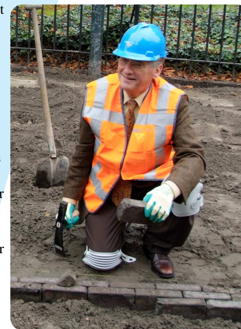
Het centrum van Ouddorp ondergaat een grondige renovatie. Wethouder Admiraal, na operatie, weer aan de slag voor Gemeente Goedereede.
